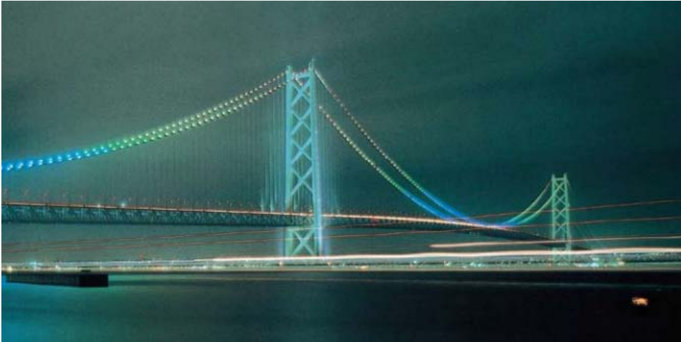
Vue de nuit du pont Akashi-Kaikyo.
