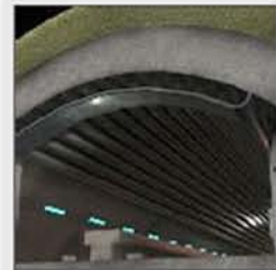
Tunnel de service supérieur
