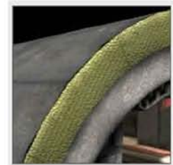
Le joint entre 2 des 54.000 sections du tunnel
