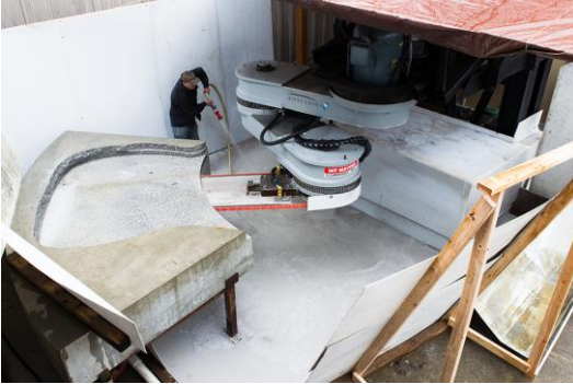
Le robot qui creuse les marches d'escalier dans les parois du puits.
