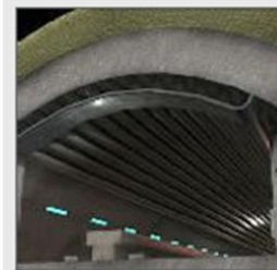
Tunnel de service supérieur
