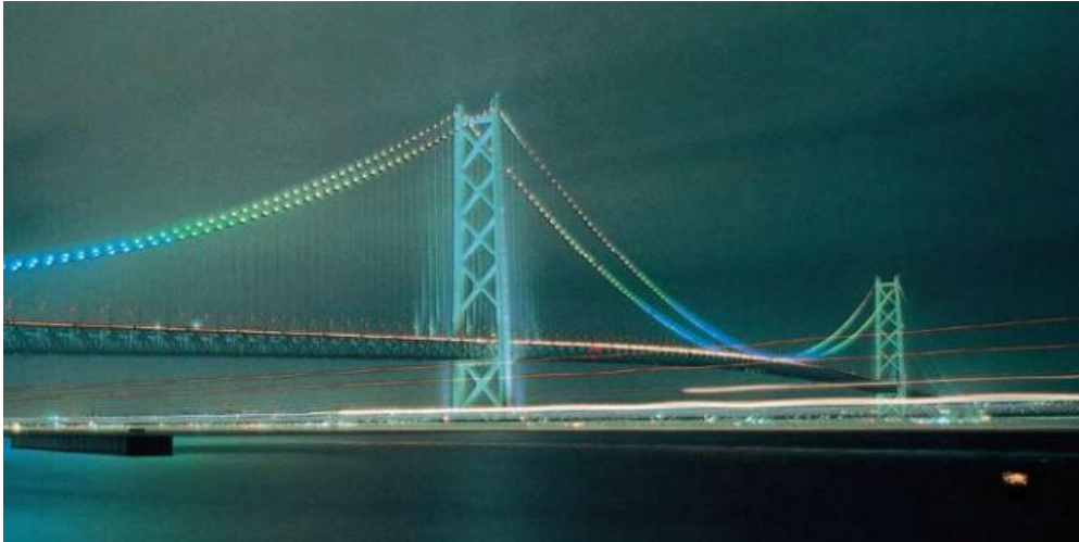
Vue de nuit du pont Akashi-Kaikyo.
