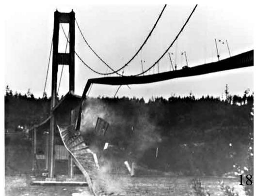
assez basses. On évite les prises d'amplitude par des amortisseurs dynamiques, par des structures les plus rigides possibles (pour augmenter les fréquences de résonance) et en évitant les couplages entre les divers modes de résonance.
